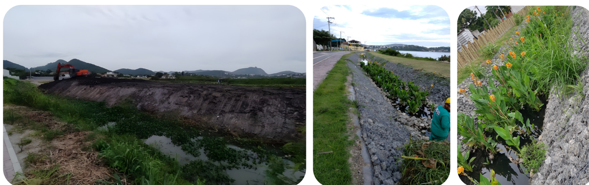
Figura 8 – Requalificação do canal de cintura com ilhas de macrófitas
