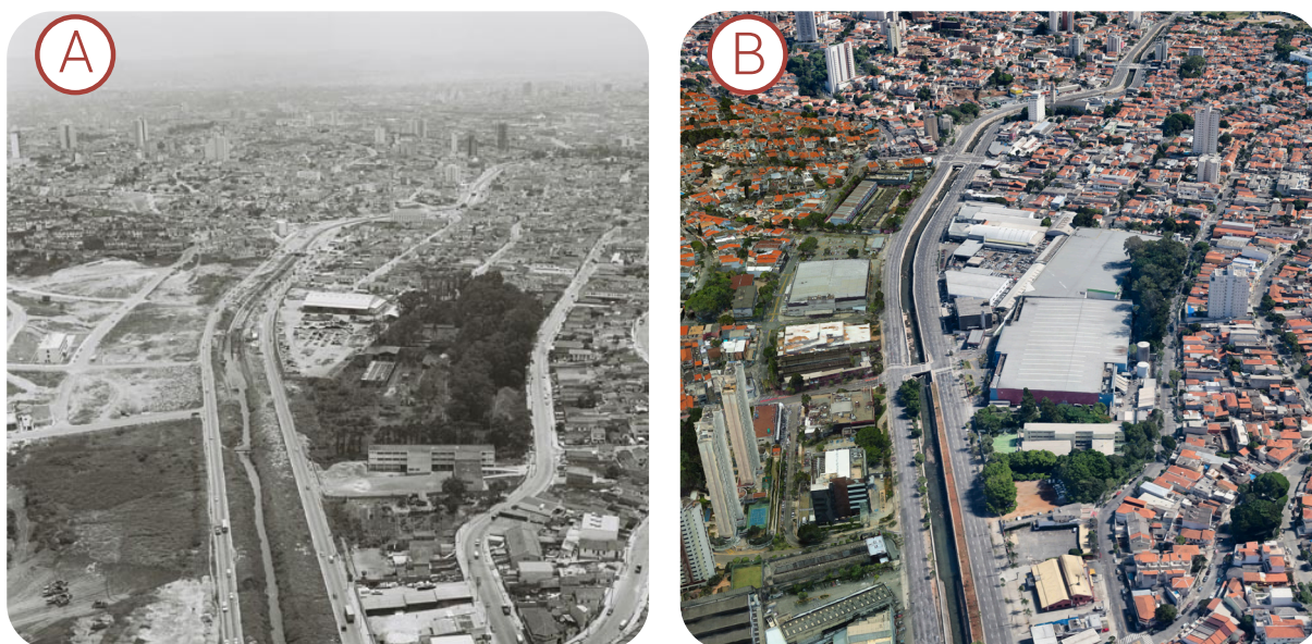
Figura 3 - Retificação do Córrego Ipiranga e implantação da Av. Água Funda, atualmente Av. Dr. Ricardo Jafet, São Paulo/SP
