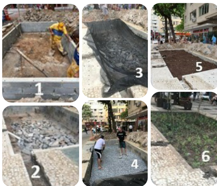
Figura 5 - Passo a passo da construção do Projeto Piloto do jardim de chuva da Rua Almirante Gonçalves
