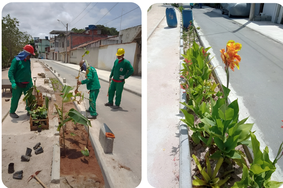
Figura 7 – Biovaletas, em fases de construção e concluídas
