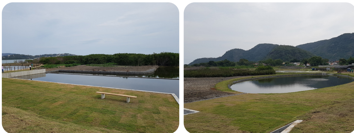
Figura 5 – Vertedouro e bacia de sedimentação do Sistema Cafubá
