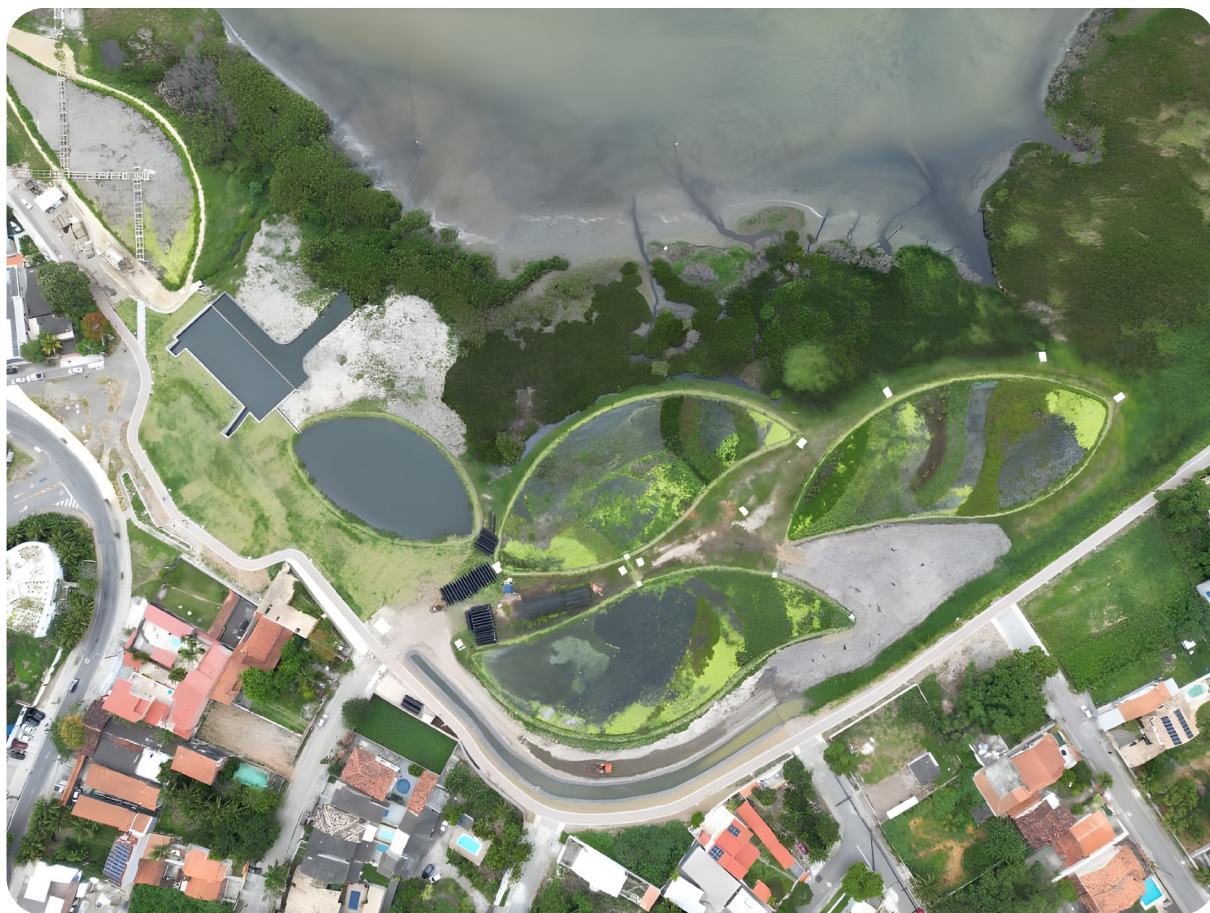
Figura 3 – Depois da implantação do POP: sistema de jardins filtrantes da Bacia do Rio Cafubá
