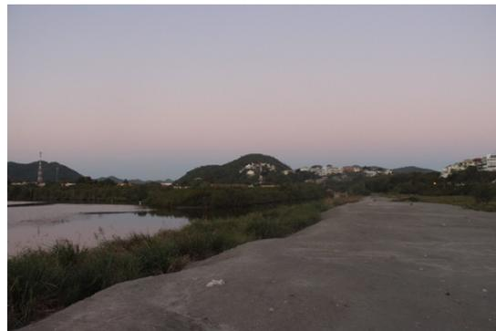
Figura 13-d. Dique construído a partir de material dragado.
