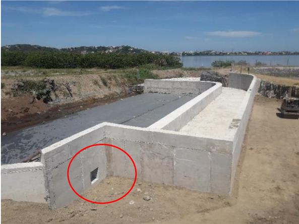
**Foto 1.** Vertedouro do rio Arrozal em execução. Destaque em vermelho para orifício que irá direcionar as águas do rio Arrozal ao sistema de tratamento das águas fluviais em Sbn do POP
