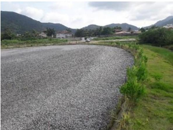
**Foto 2.** Bacia de Sedimentação já executada do sistema de tratamento de águas fluviais em Sbn
