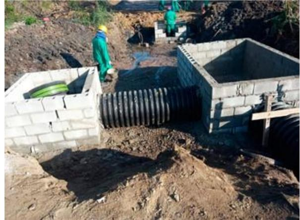
**Foto 3.** Execução de caixas de passagem entre os jardins filtrantes do sistema de tratamento de águas fluviais em Sbn da Lagoa de Piratininga
