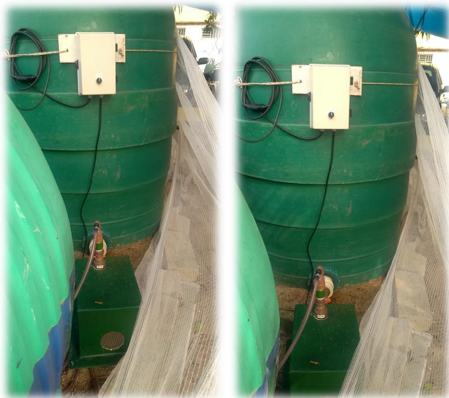
Foto 11 – Reservatórios Biorremediador, Painel e Bomba para aplicação
