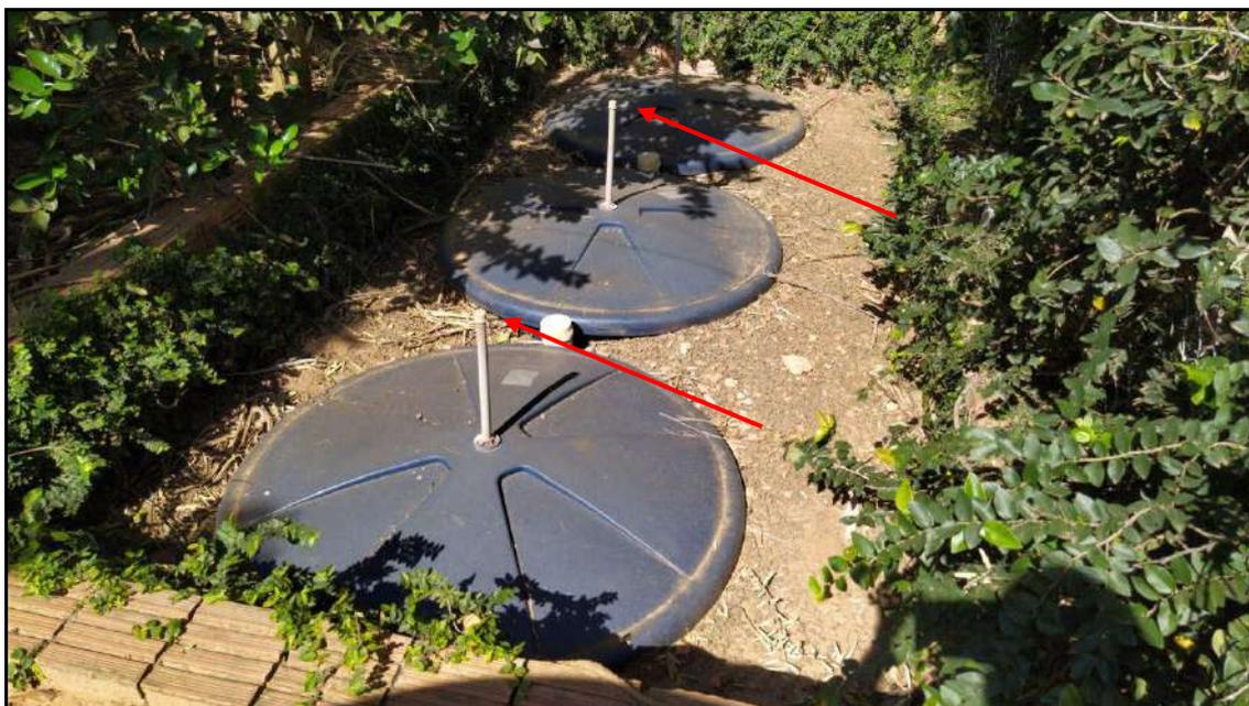
**Figura 6** – Fossa Séptica Biodigestora. Em destaque vermelho: chaminé para a saída de gás.
