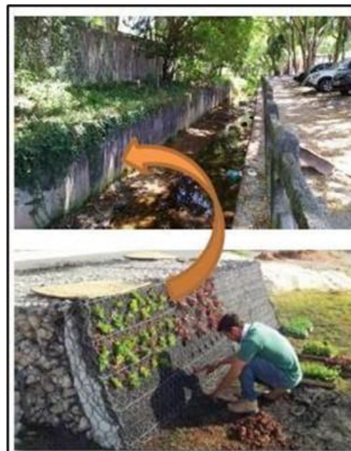
Figura 9.- Exemplo de solução proposta para recuperação do Rio Jacaré na área do bicicletário. Afixação do talude com tela vegetada.
