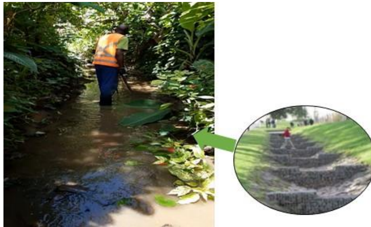
Figura 11.- Imagens ilustrativas de solução proposta – inserção de degrau de nível para aumento da biodiversidade.
