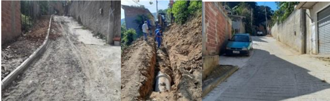
Figura 3. -Fotos das obras da comunidade do Vale Verde mostrando o antes, durante as obras de drenagem e o depois com a drenagem e a pavimentação concluídas.
