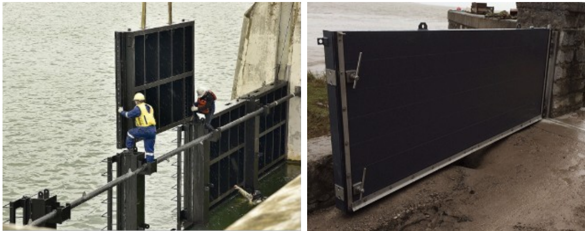
Figura 7.1.1-1. Exemplos de comporta do tipo stop-log , que deverá ser instalada no desemboque do túnel.
