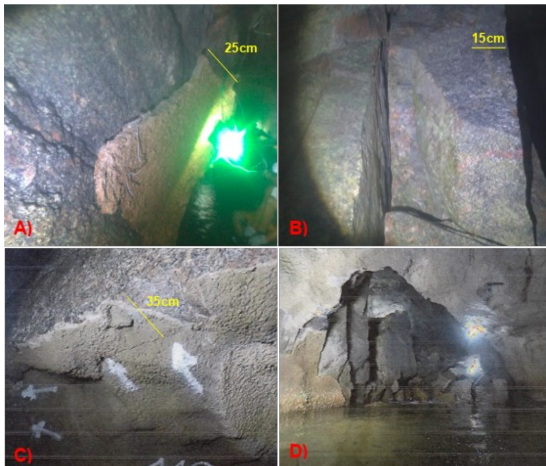
Figura 6.1-2. A) Desplacamento lateral; B) Bloco em coluna que foi removido; C) Trincas no teto paralelo a foliação, que forma corpo tabular que se prende à parede da capela de 110m; C) Trincas mostrando bloco paralelo a foliação; e D) Vista da capela de 110m, apresentada no Anexo TP-04-20-an.
