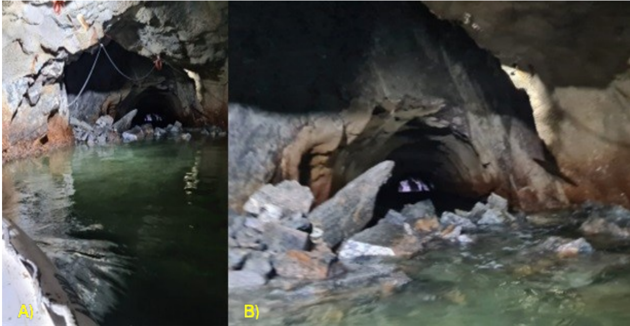
Figura 6.3-3. A) Situação em 13/01/21 mostrando a capela do trecho 110m, mostrando acentuada queda de blocos, quando comprado a situação do dia anterior ( Figura 6.3-2 ). B) Outra vista do mesmo trecho.
